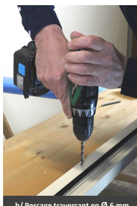
b/ Perçage traversant en Ø 6 mm
